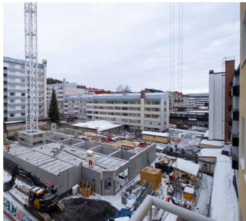
KOAS Syke työmaa, talvi 2024
